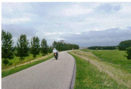
Figur 22: Et dige, der er større end nødvendigt, hvor der opnås en konkret mulighed for at implementere en stifunktion og digets bredde skaber tryghed for brugerne af stien.
