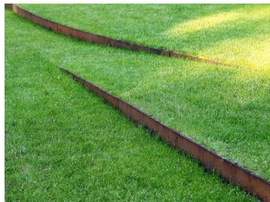
Figur 29, Støttemuren. Støttemure kan være med til at give et område identitet afhængig af materialevalget og udformningen. En støttemur med en bred topflade inviterer til ophold, mens en plade i fx cortenstål fremstår som et element, der holder jord tilbage.
