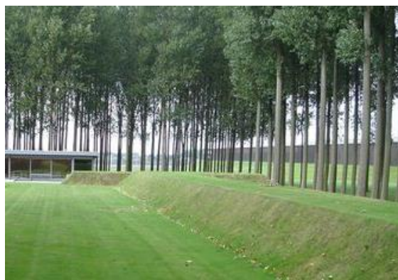
Figur 44, Et markant dige virker som et karakteristisk landskabselement. På bagsiden er der plads til forsinkelse af bagvand.
