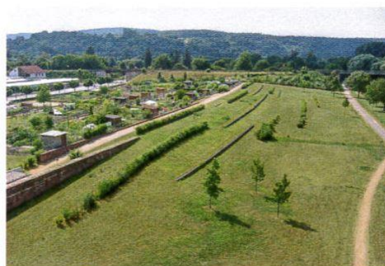
Figur 23: Et landskab med et diges funktion. Her er landskabet udformet med terrasser og skråningerne er ikke markante, hvilket gør digefunktionen usynlig for den, der ikke kigger efter det.
