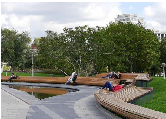
Figur 43, Bagvand ledes til en lavning i belægningen, der fungerer som forsinkelse for regnvandet.
