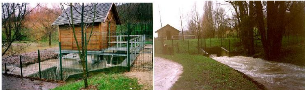
Figur 8. Eksempel på dynamisk styringsanlæg. Bièvre floden i Frankrig har tidligere oplevet mange problemer med oversvømmelse. De har derfor bygget fire tilbageholdelsesbassiner med volumener på mellem 27.000 og 155.000 m 3 og indført en automatisk dynamisk styrestrategi med spjæld som tilbageholder vand i bassinerne. Eksempel fra Krügers notat om Foranalyse – fordele og ulempe ved forskellige typer styring [3].
