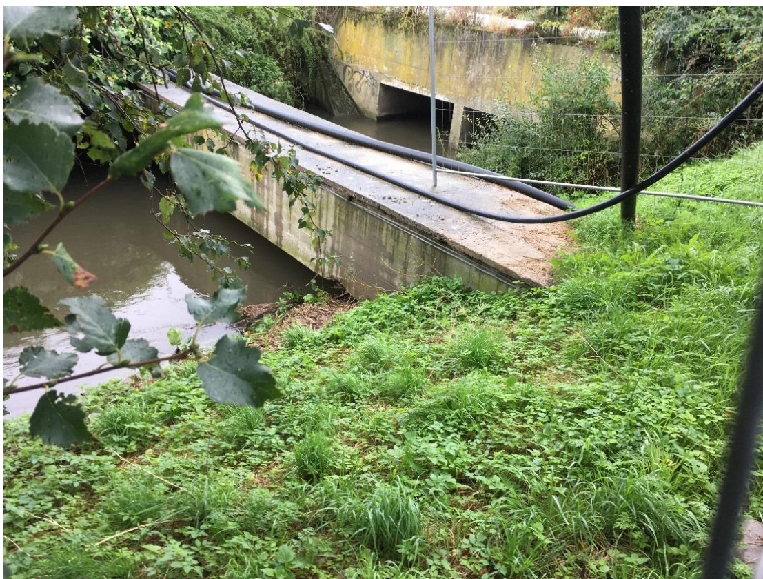
Figur 14. Eksempler på flaskehalse i åen, der skal omlægges eller ombygges. Opstrøms bagerst i billedet broen over Harrestrup Å ved Sønderkær, og nedstrøms forrest i billedet en krydsende ledning.
