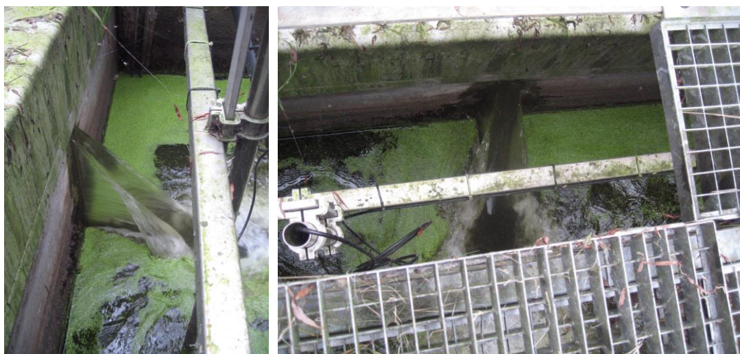
Figur 9. Afløbet fra Sjælsø til Usserød Å er et fuldautomatisk spjæld. Spjældet er styret via en PLC, der har forbindelse til et SRO-anlæg, som ud fra vandstanden i Sjælsø og kritiske punkter nedstrøms på åen løbende regulerer vandføringen ud af søen og ned gennem Usserød Å. Spjældet er konstrueret således, at det er faunapassabelt helt ned til meget små vandføringer. Eksempel fra Krügers notat om Foranalyse – fordele og ulempe ved forskellige typer styring [3].
